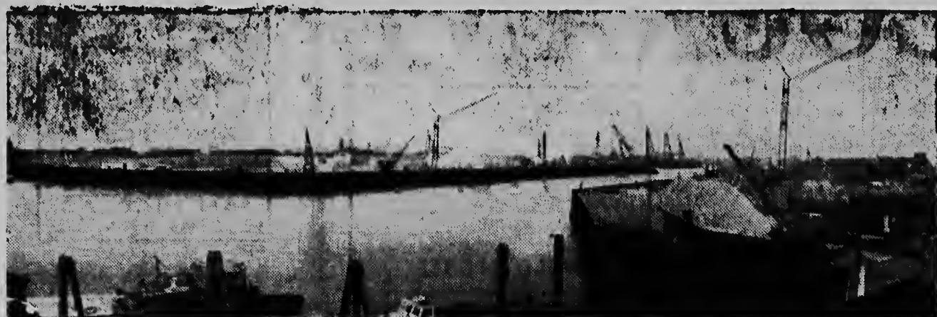
In de Hollandse IJssel is een groot project onderhanden: de bouw van een stormvloedkering, die de constructie omvat van een schutsluit (een afsluiting van de rivier door twee beweegbare schuiven) en de overbrugging van de rivier. Deze panoramafoto geeft een overzicht van de stand der werkzaamheden aan de lage zijde van het project (de naar zee gekeerde zijde).
